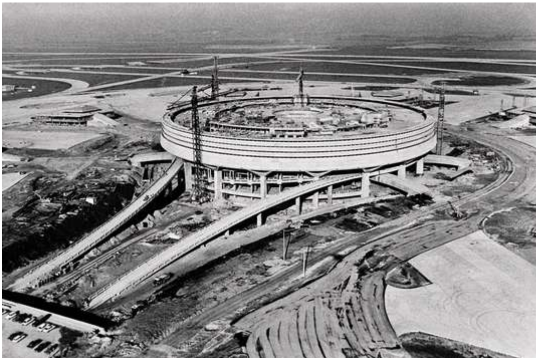
Le chantier du terminal 1 de l'aéroport de Roissy, en 1972. AFP
